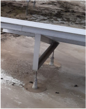
KO KOTVENÍ DRŽÁKŮ FE PANELŮ - ZÁVITOVÉ TYČE PRODLOUŽENÍ NEREZ TYČÍ S NEREZ MATICEMI
